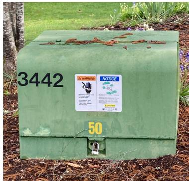
В зеленой будке находится высоковольтное оборудование, перемещающее огромное количество электроэнергии по близлежащим подземным кабелям. Копая землю вблизи наземных трансформаторов, даже с помощью ручного садового совка, вы рискуете задеть или перерезать подземные линии электропередач, что может привести к массовым отключениям электроэнергии, серьезным травмам или смерти.
